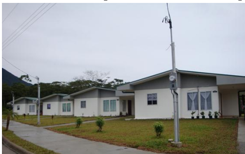
Casas de "Nueva Cinchona" agosto 2011 - Fuente: el autor
